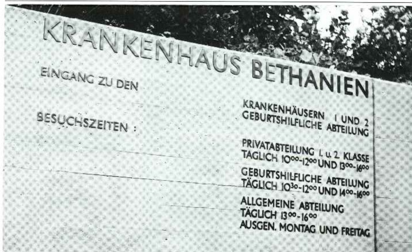
Aluminiumbuchstaben blaugrau eloxiert mit Gewindestiften auf Beton befestigt.
