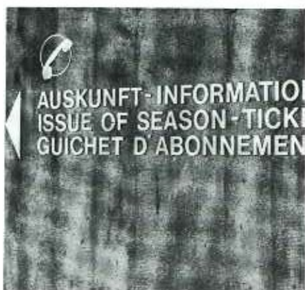
Aluminiumbuchstaben 3 mm dick auf Beton.
